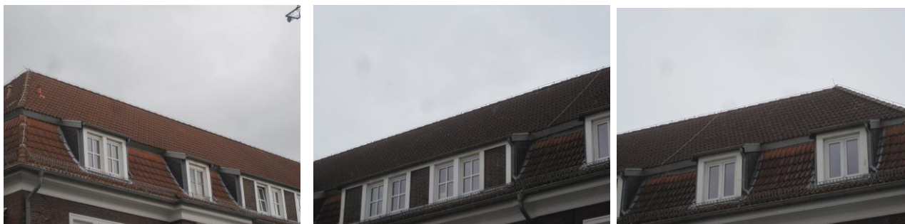
Abbildung 4: Blick auf das Schrägdach mit den Gauben
